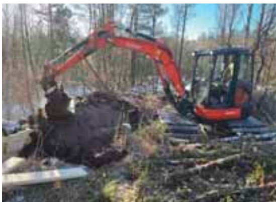
Einsatz von modernen kleinen und leistungsstarken Baggern mit extra breiten und bodenschonenden Ketten für die Moorrenaturierung
