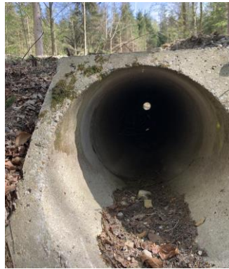
Rohrdurchlass unter der Straße
