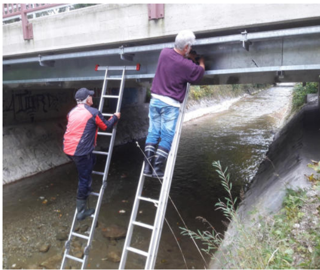
Schwebende Berme über den Hirschbach (Foto: F. Speer)
