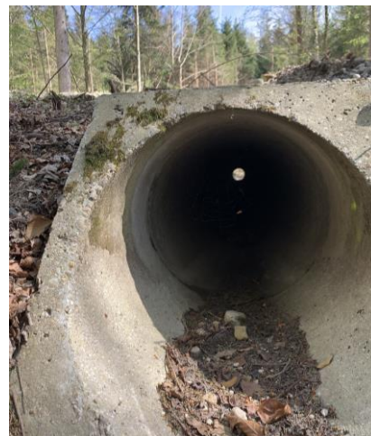
Rohrdurchlass unter der Straße
