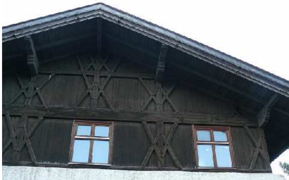
Abb 12: Hier wurden vor kurzem neue Fenster eingebaut! Die Firmenaufkleber sind noch zu sehen. Der Abbriss solcher Gebäude ist volkswirtschaftlich nicht sinnvoll und abzulehnen!
