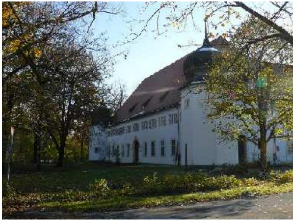
Abb. 1: Das Offiziersgebäude von Norden und
