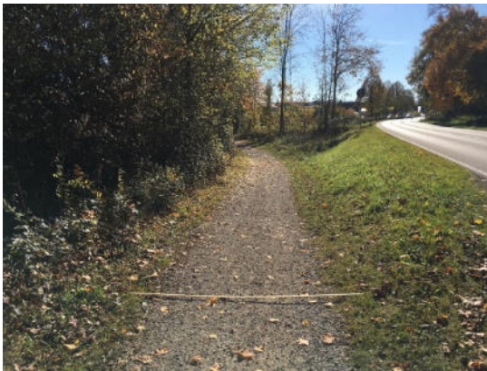
V.a. auf der westlichen Seite des bisherigen Weges sind auf vielen Streckenabschnitten kleine Böschungen vorhanden. Bei einer Wegverbreiterung müsste jeweils abgegraben (oder auch mal aufgeschüttet) werden. Wie sind hier die Randanschlüsse geplant?
