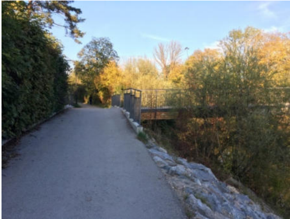
Im Bereich Walsersteg: Asphaltierung bis unmittelbar an die Hecke heran (bzw. auch bis an die Loisch-Böschung). Hier können sich keine Übergangssäume mehr bilden.
