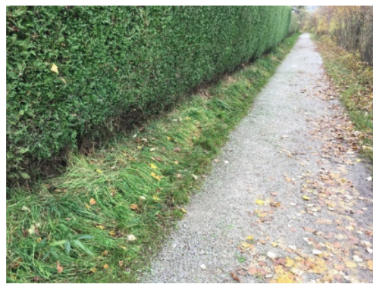
V.a. auf der westlichen Seite des bisherigen Weges sind auf vielen Streckenabschnitten kleine Böschungen vorhanden. Bei einer Wegverbreiterung müsste jeweils abgegraben (oder auch mal aufgeschüttet) werden. Wie sind hier die Randanschlüsse geplant?
