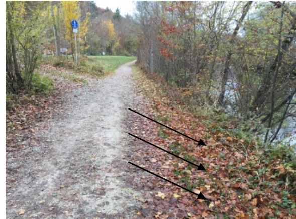
Im Bereich der Mündung des landwirtschaftlichen Weges nach der Abkehr der Loisch von der St 2370 hängt der Weg stark zur Loisch-Böschung hin
