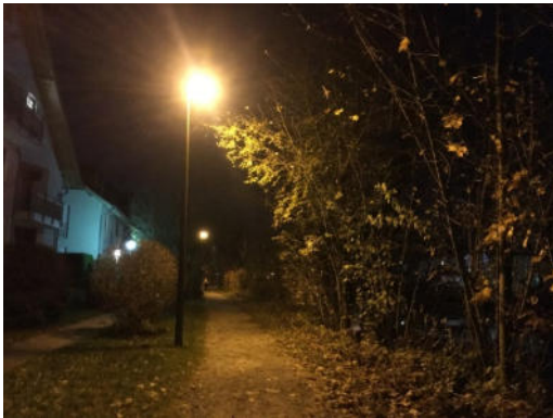
Bisherige Beleuchtung mit Straßen- u. Kugellampen an Wohnanlagen im Norden
